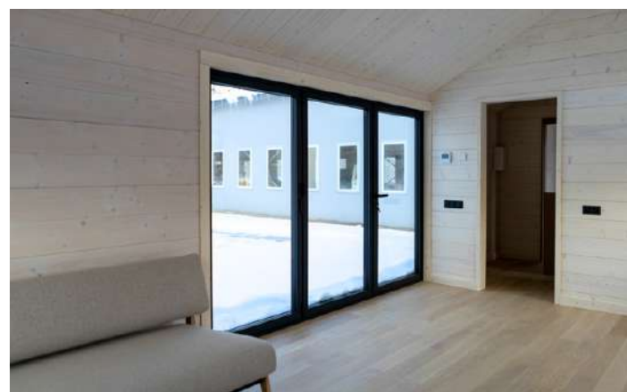
Ieejas zona ar alumīnija salokāmi bīdāmo durvju sistēmu
